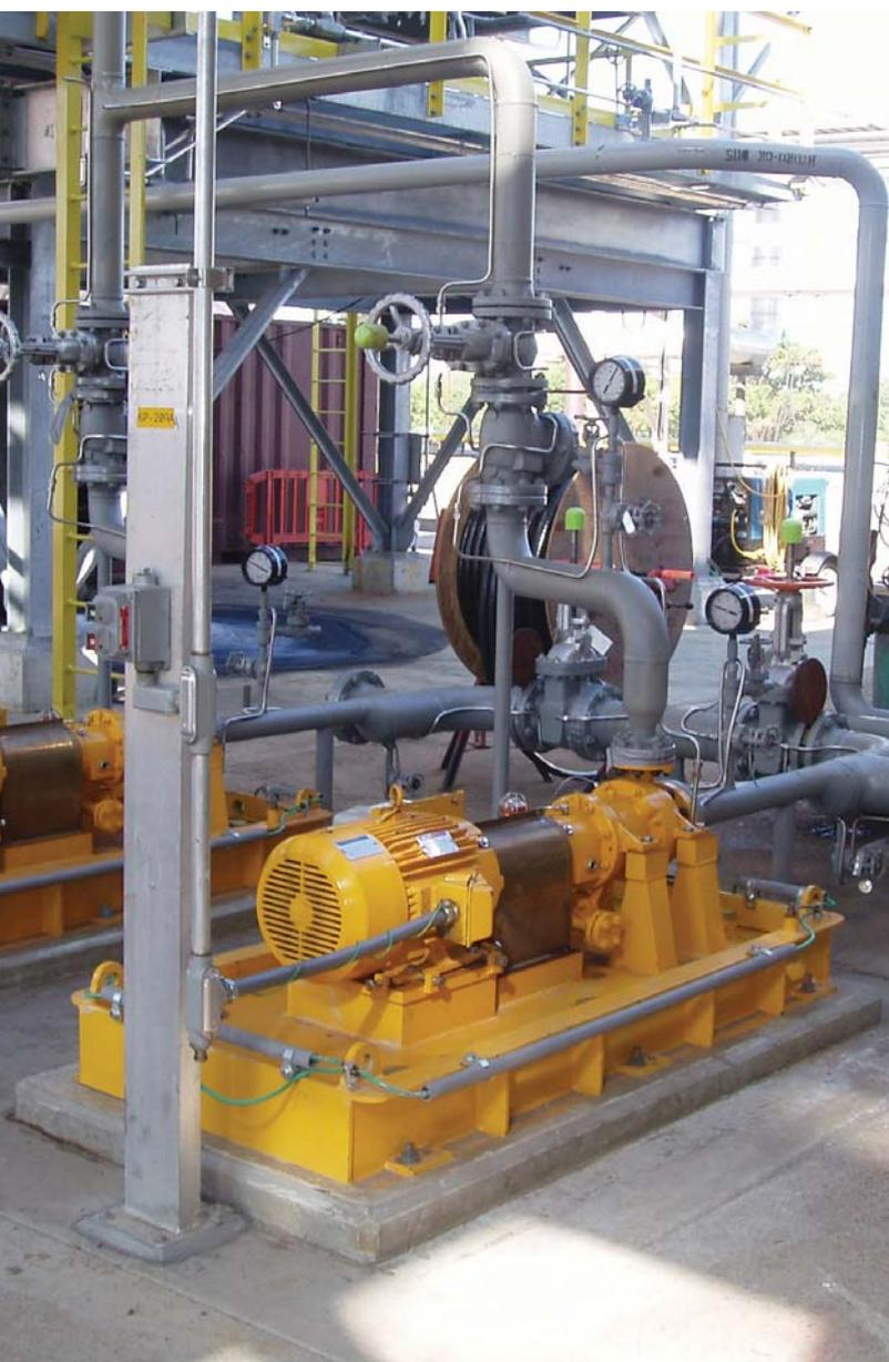
Серия GSP – это насосы, изготовленные на базе привода HMD Kontro GS в соответствии со спецификациями стандарта API 685 и предназначенные для тяжелых режимов работы.
